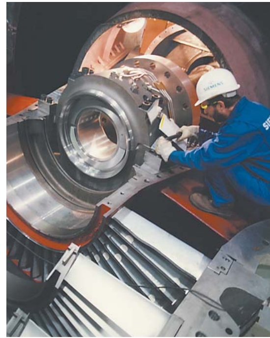
Arbeiten am Lager einer SGT5-4000F-Gasturbine.
